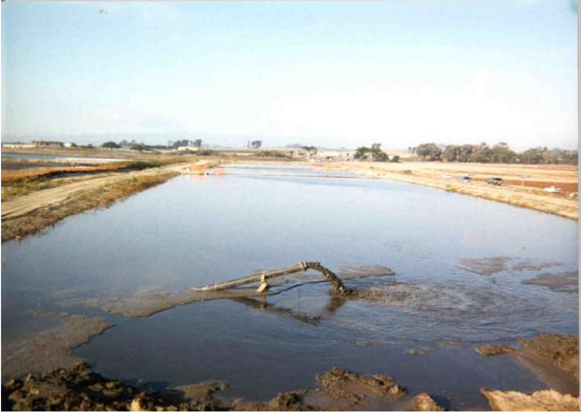
Moss Landing Limanında, Sedimen susuzlaştırma ve muamele havuzları (California)(Krause ve McDonell, 2000)
