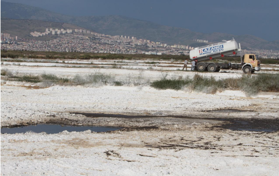
18 Mayıs 2011, Çiğli Atıksu Arıtma Tesisi (Çamur depolama sonrası kireç dökümü)
