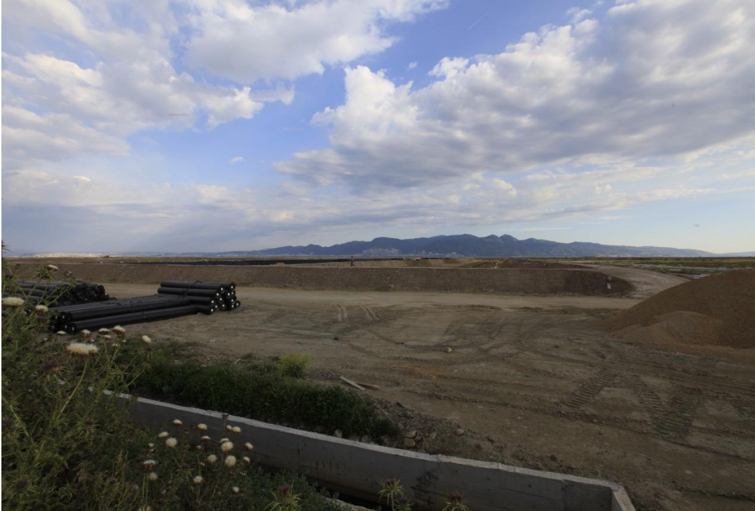
Çiğli Atıksu Arıtma Tesisi Çamur Depo Havuzlarının açılmasına ait bir görüntü
