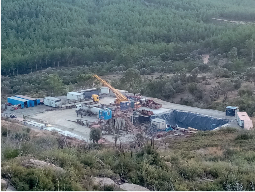
157 ada, 2 parselde kurulması planlanan JES (Jeotermal Enerji Santrali) projesinin güncel durumu.
